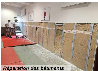
Réparation des bâtiments
