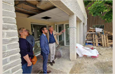
Visite du chantier de l'EHPAD Sainte-Cécile
